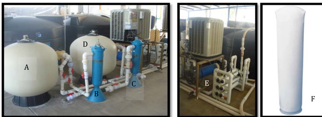
Figura 11. – Sistema de filtrado del agua de mar del laboratorio de cultivo de moluscos del CIBNOR.
