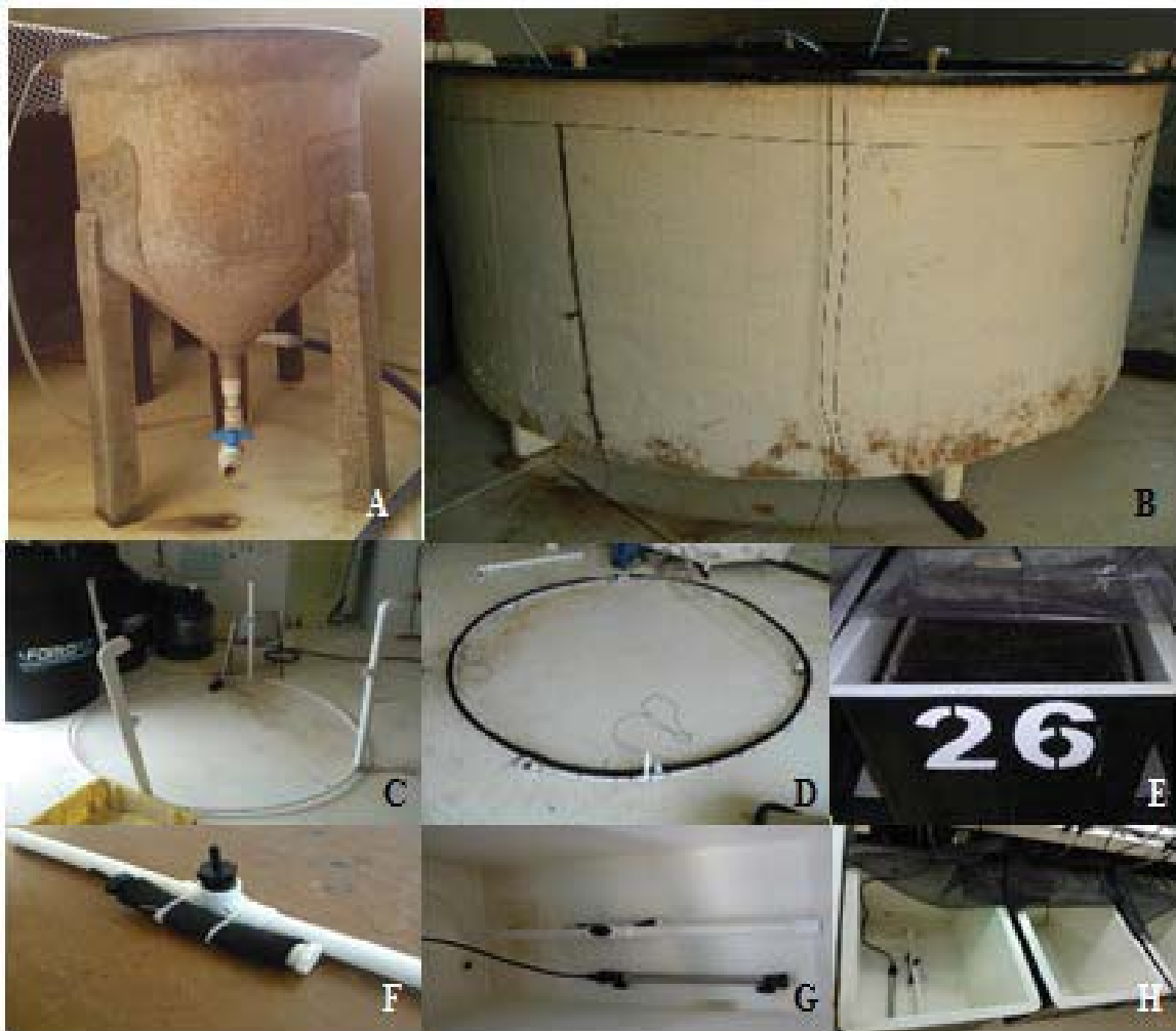
Figura 1.- Componentes del sistema A) Sedimentador cilindo-cónico B) Tanque de peces capacidad 3000 L C) Base del sistema de aireación D) Sistema de aireación con manguera multiporo y micro burbuja E) Mineralizador quimioautótrofos (1 unidad) F) Skimmer G) y H) Aireación en mineralizadores quimioautótrofos.
