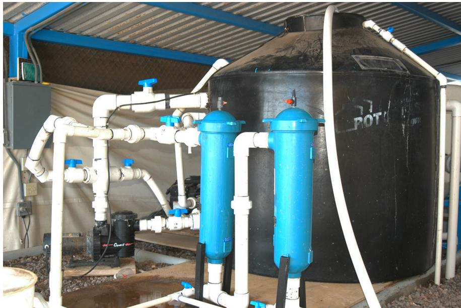
Figura 4. Tinaco de 1000 L de capacidad integrado con una bomba de 1 HP, cuyo bombeo pasa a través de un filtro de arena y dos filtros de bolsa (color azul), regresando a los tanques de reproducción.
