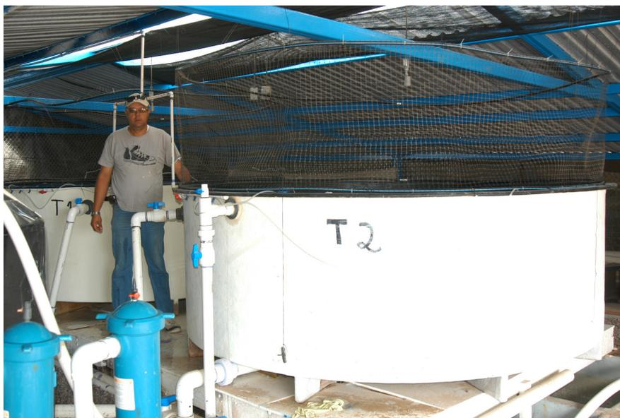
Figura 3. Tanques de reproducción de *Lutjanus peru* (Tanque 1) y *Lutjanus argentiventris* (Tanque 2), cada uno con capacidad de 7 toneladas de agua de mar.
