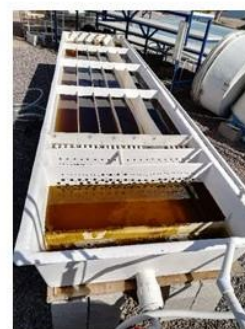
Sistema de canaletas
