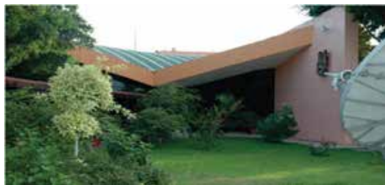
Instalaciones del CIIDIR-IPN ubicadas en Guasave, Sinaloa.
