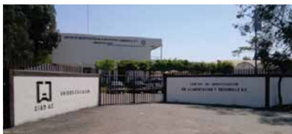
Instalaciones actuales del CIAD, A.C. Unidad Culiacán, Sinaloa.
