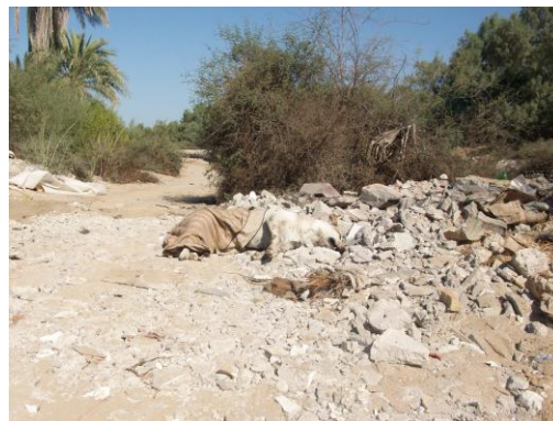
Camino antiguo de acceso a las instalaciones de la planta de tratamiento de aguas residuales.
