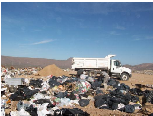
Volteo de tierra y arena para cobertura de residuos.
