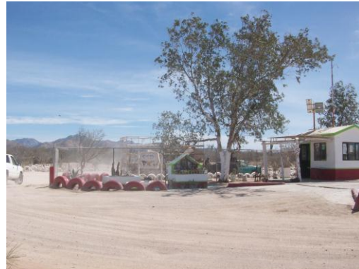
Vista interior del acceso de entrada
