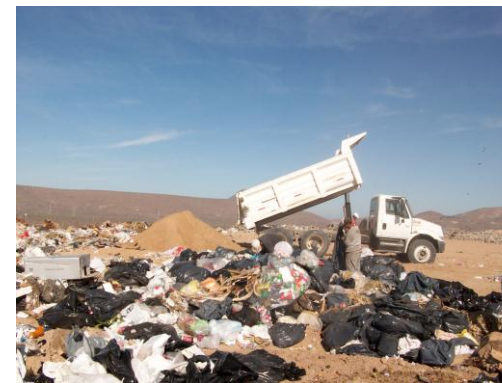
Volteo de tierra y arena para cobertura de residuos.
