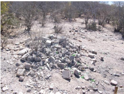
Tramo de acceso a las instalaciones del relleno sanitario. Residuos de construcción.
