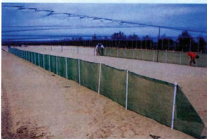
**Foto 5.** Instalación de malla rompevientos
