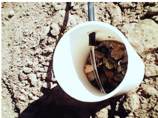
Figura 16. Receptor de sistema RSD que conecta con difusor subterráneo, recibiendo agua.
